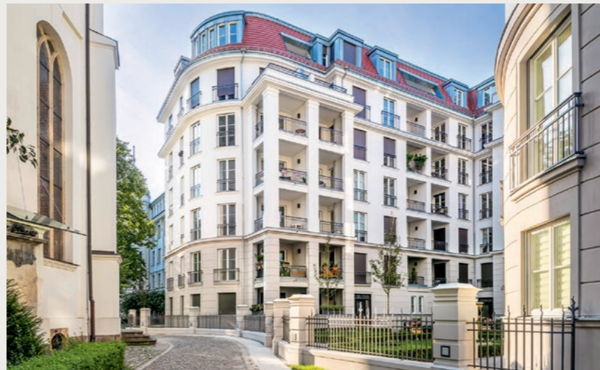
Wohnhaus Klostersgärten, Berlin-Mitte, 48 Wohnungen, Fertigstellung 2017
