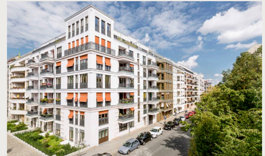
Wohnensemble Zillegärten, Berlin-Charlottenburg, 72 Wohnungen, Fertigstellung 2016
